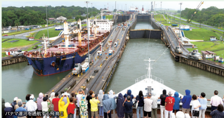
パナマ地峡を横断してカリブ海(大西洋)と太平洋を結ぶ約80kmの運河。高低差のある水路を船舶がロック(閘門)を利用して進みます。
