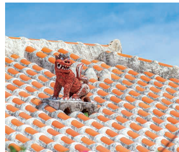
竹富島の古民家赤瓦屋根(石垣島)
